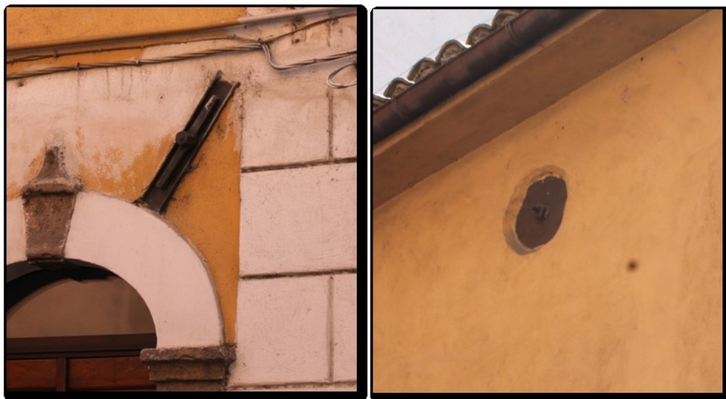
Figura 5-36 Borgo San Rocco: rinforzi strutturali
