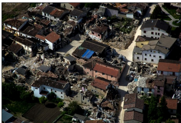
Figura 2-7 Effetti del terremoto di L'Aquila del 2009 sul tessuto urbano di Onna
