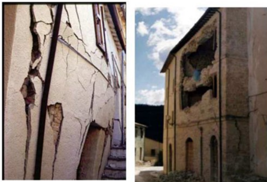
Figura 3-7 Esempi di meccanismi di flessione verticale su edifici in muratura
