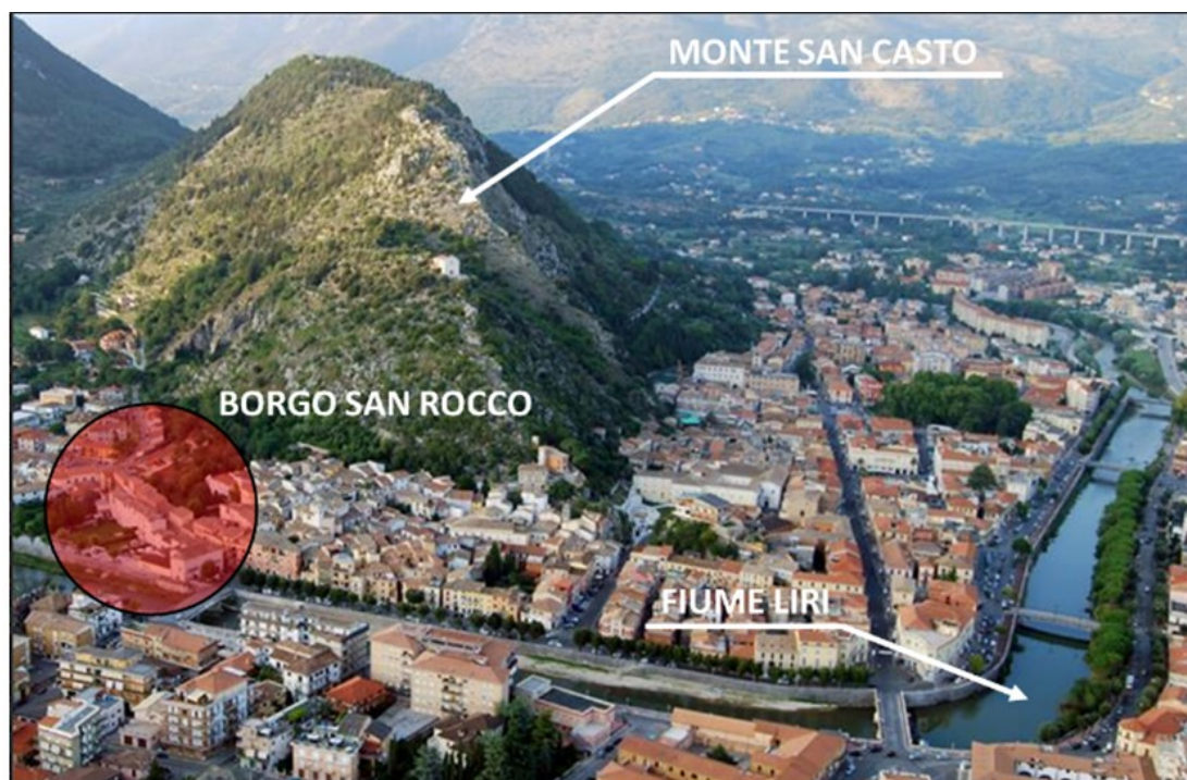
Figura 5-5 Vista aerea del centro storico di Sora ed ubicazione di Borgo San Rocco
