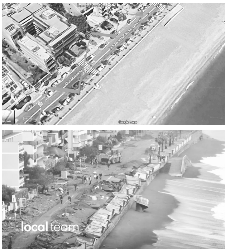
Fig. 20 – Il tratto costiero di Furci Siculo prima (in alto, Google Maps) e dopo (in basso, fotogramma tratto da un filmato pubblicato sul sito Local Team , localteam.it/video/i-danni-sul-lungomare-di-furci-siculo-dopo-la-mareggiata-drone-1769076194320 ) la mareggiata provocata dal ciclone Harry del 19-21 gennaio 2026
