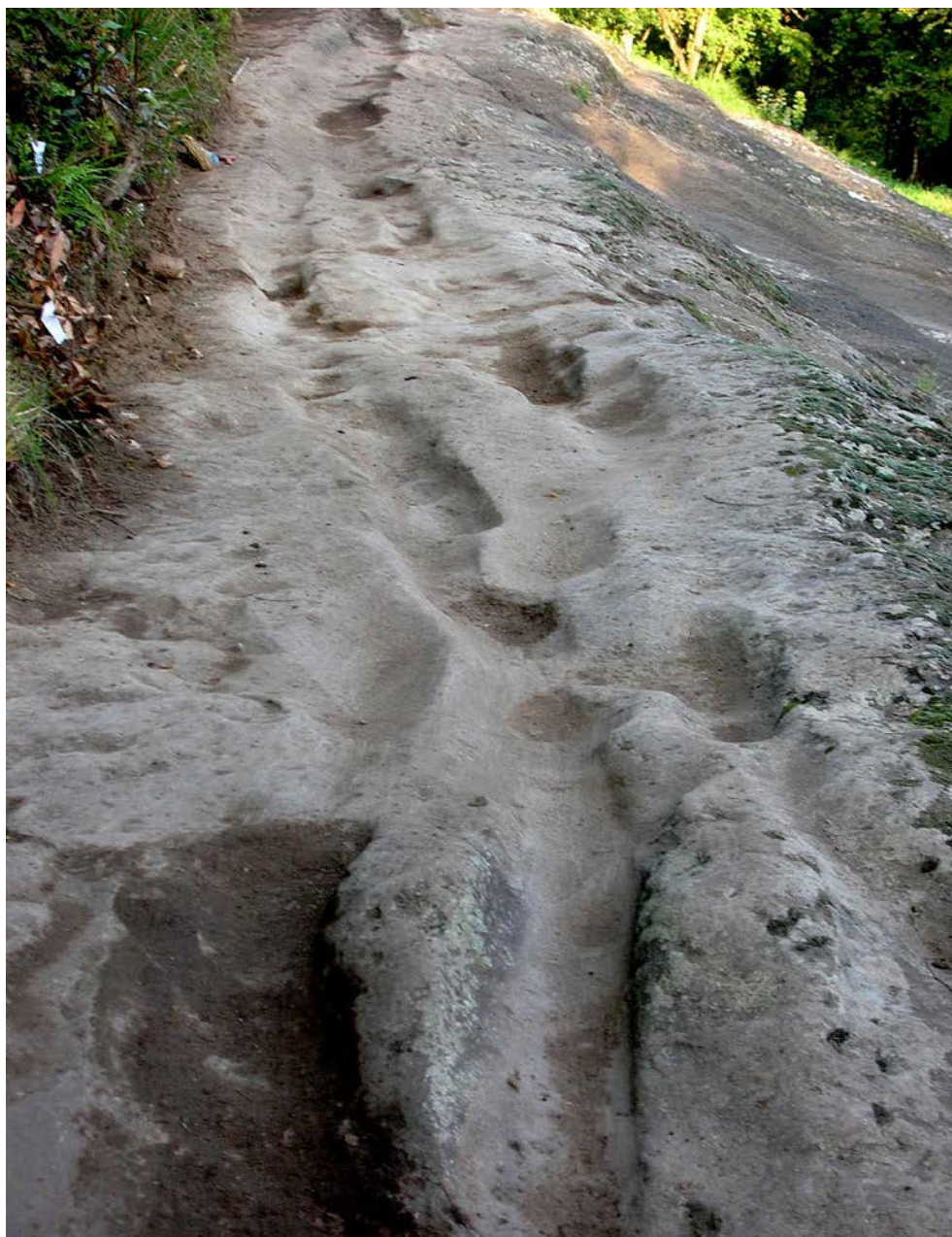
Figura 12.3 Il tratto iniziale del sentiero preistorico P1 come si presentava il 26 ottobre 2005, alla fine dei lavori di pulizia (Vista da Ovest).
