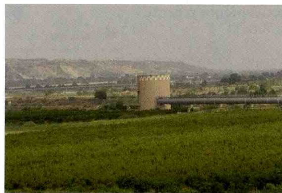
Fig. 13. Grande condotta nella bassa Val d'Agri. I grandi acquedotti della Basilicata, attraversata a nord anche dall'Acquedotto Pugliese (Pertusillo, Sinni, Ofanto, Agri, Basento-Camastra, Frida Caramola), rappresentano una delle esperienze più significative in Italia di gestione e trasferimento delle acque (foto A. Riggio)
