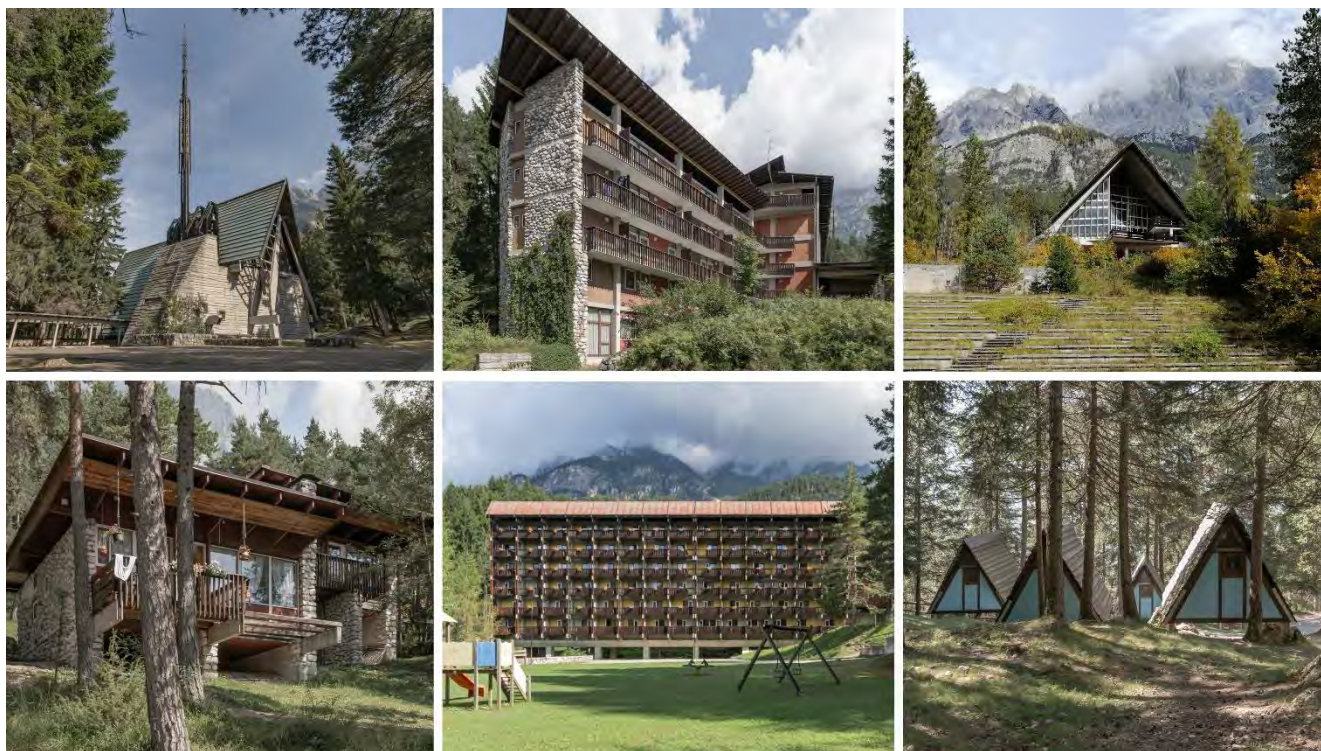
Figura 1. Le strutture del Villaggio ENI di Borca di Cadore
