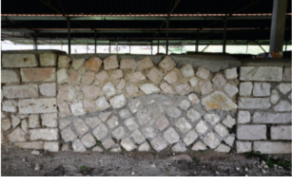
Fig. 5: Villa di Cottanello: tamponatura tra gli ambienti 14 e 15 da est; la porzione originaria (in alto) è stata integrata dal restauro fino alla quota di calpestio della fase II (da GASPARINI, RESTAINO 2017, p. 56, fig. 19).
