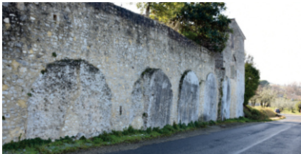
Fig. 25: Casperia, Paranzano, i muri in opus reticulatum pertinenti al terrazzamento di una villa romana (foto: C. Sfameni).
