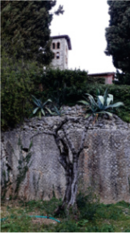
Fig. 23: Casperia, chiesa di S. Maria in Legarano: il muro di terrazzamento superiore e il campanile (foto: C. Sfamini).
