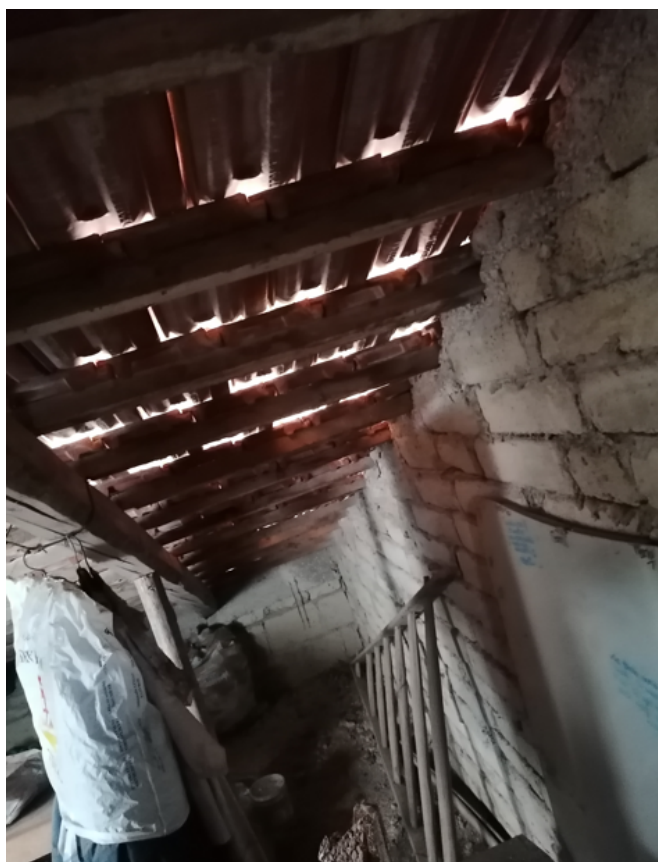
Figura 10. Caso di studio A: sottotetto non isolato
