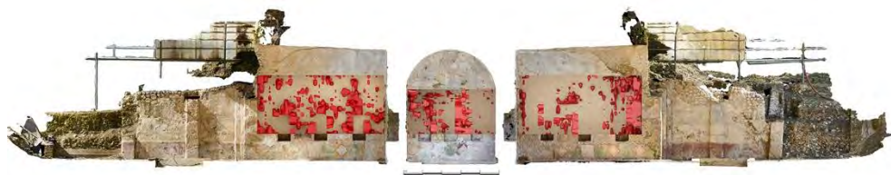
Figura 20 – 'Scavo virtuale', rappresentazione del quadro fessurativo 3D sulle pareti.
